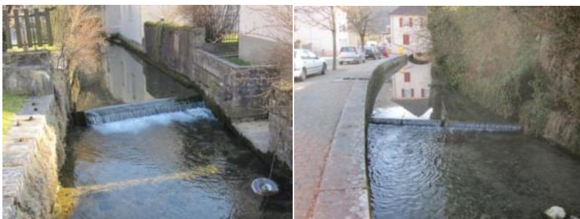
Figure 2 bis : petits seuils piscicoles dans le lit mineur du ruisseau
