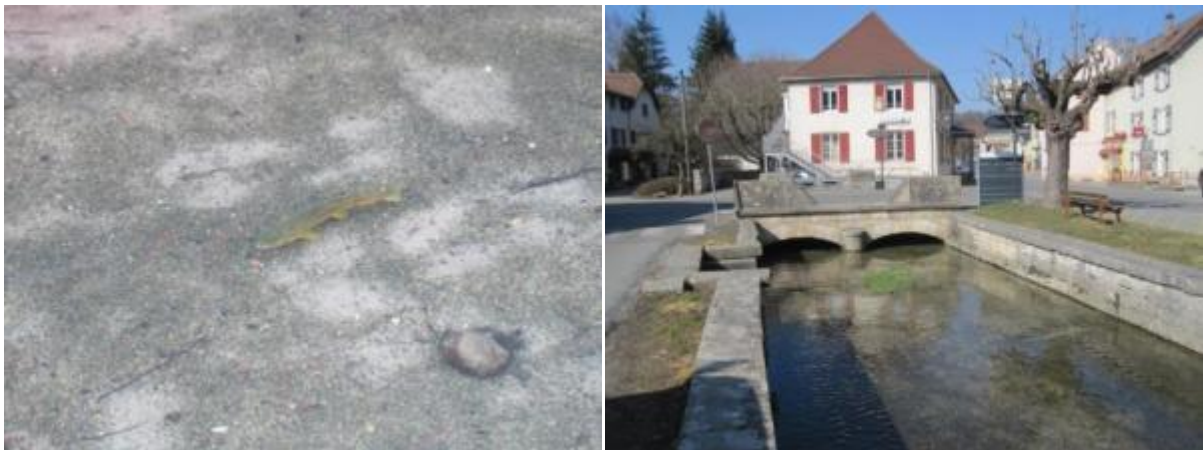
Figure 2 : Fonds graveleux du ruisseau et perrés dans la traversée du bourg de Colombier Fontaine
