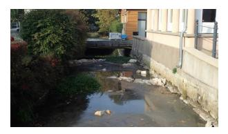
Réalisation des banquettes, de l'épis et des abris piscicoles en aval du bâtiment de la Poste.
